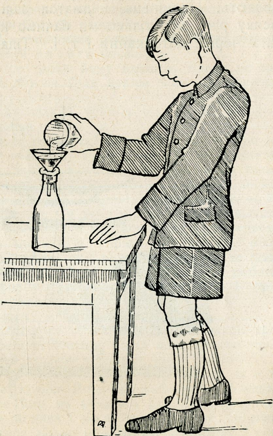
Хлопчик робить дослід: ллє воду до лійки, яка в шийці є овинєна вогкою шматкою (або глиною). — Вода не входить до пляшки лиш остає в лійці.
