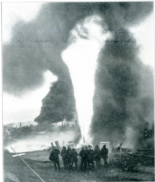
Одинацять вибухових шибів горить і то від одного громового удару! За громадкою нафтярських робітників два азбестові паравани, якими заслонюють ся, підходячи ближше до огню.
