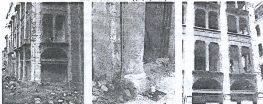
1.2. В процессе ремонтно-восстановительных работ
