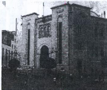
Здание Парламента в Бейруте. Реставрация 1995 г.
