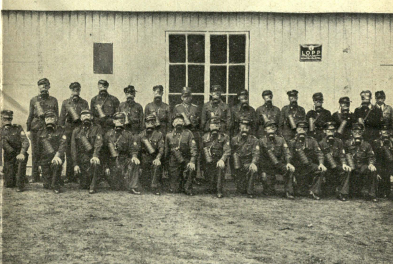
Członkowie P. W. w maskach, na tle nowej Komory Gazowej przy ul. Leszno 72.
