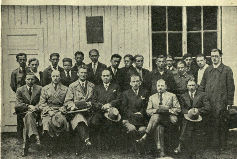
Grupa ofiarodawców, którzy przez złożenie sum pieniężnych i materiałów, przyczynili się do powstania Komory Gazowej. Obok nich uczniowie Szkoły im. Konarskiego, którzy pracowali przy budowie Komory.
