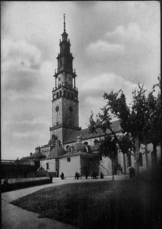
Częstochowa. Wieża Klasztorna
