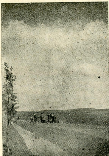
Копають отвертий рів для відводнення сіножатей в Грибовичах біля Львова.
